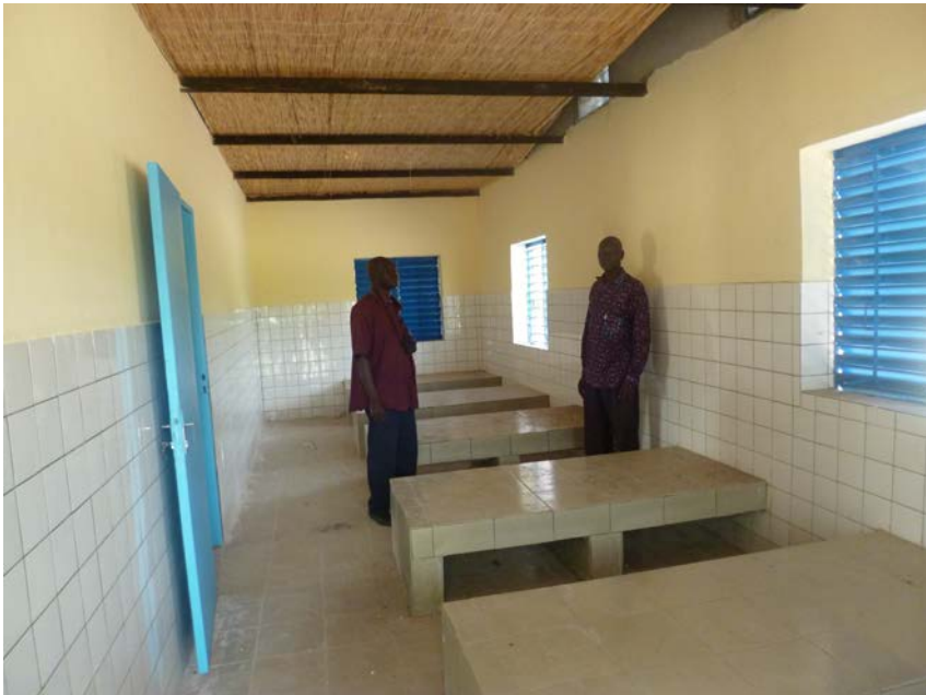
Fünfter Kontrollbesuch / Innenausbau abgeschlossen / Krankensaal des Dispensaires
