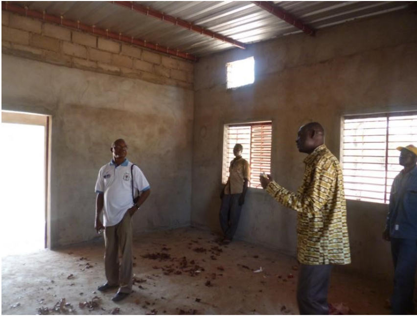
Dritter Kontrollbesuch / Rohbau fertiggestellt
